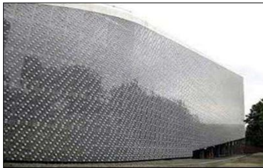
Gambar 1: Salah satu contoh konstruksi bangunan eco-ARC oleh Arthur Huang (Taipei) dengan memanfaatkan 1.8 juta botol plastik (Sumber: Jalaluddin, 2017).
